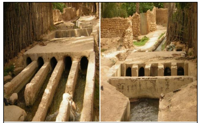
Fig.4 – Des techniques d'irrigation multiples par un bassin de distribution à l'oasis de Chetma. Source: auteur
