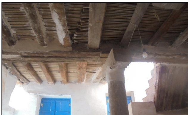
Fig. 8 – Structure en palmier et revêtement des murs par la chaux dans l'oasis Zibanaise Lichana Source: auteur
